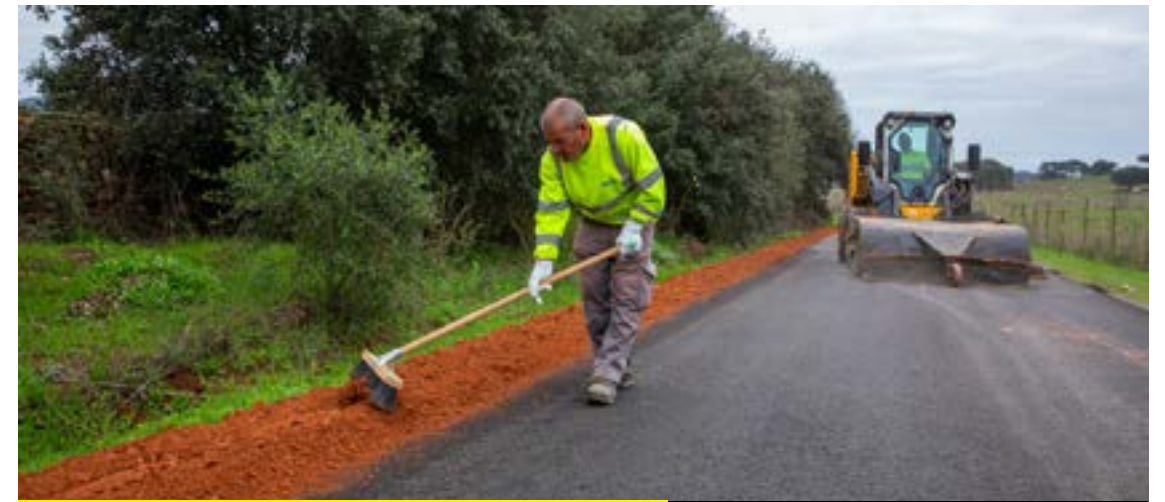
// Trabalhos de requalificação do Caminho 1050 - Fernão Teles, em Sobral da Adiça.
